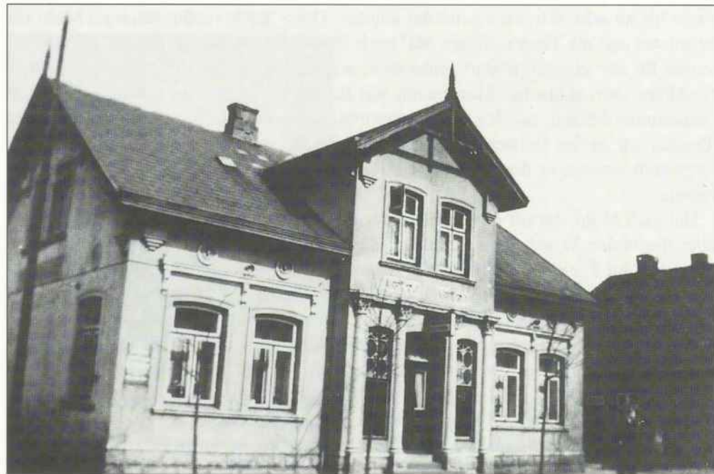
Das 1949 umgebaute Gebäude mit den vergrößerten Fenstern am Eingang
