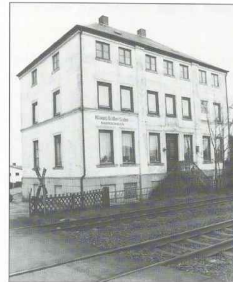
Die Aufnahme aus dem Jahre 1989 zeigt, daß das Gebäude Am Bahnhof Nr. 14 im wesentlichen nicht verändert worden ist.
