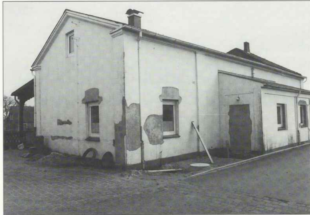
Das Empfangsgebäude wird umgebaut, und damit wird das Kapitel Horster Bahnhof, das 1844 aufgeschlagen wurde, vorerst einmal zugeschlagen.
