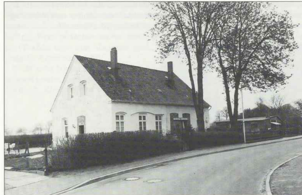
Das umgebaute erste Empfangsgebäude
