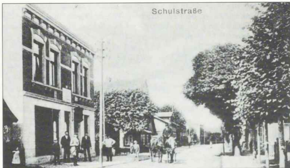
Das Wohn- und Geschäftshaus in der Schulstraße
