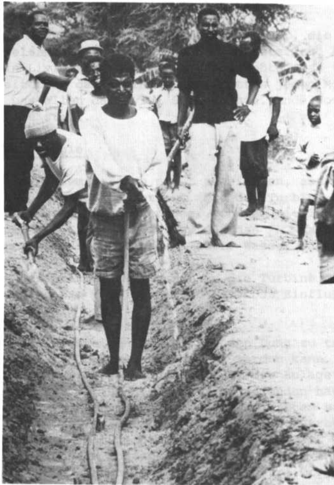
Das Kanalsystem in Buleya Malima wird instandgesetzt
