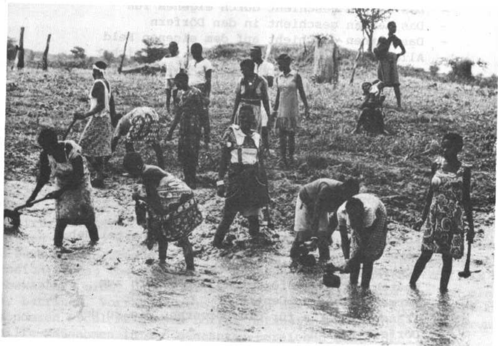
Der Kanal vom Karibasee zur Pumpe in Siatwiinda wird tiefer gegraben
