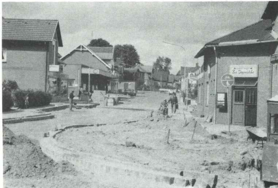
Straßen- und Dorferneuerungsarbeiten in der Hauptstraße Hohenaspe
