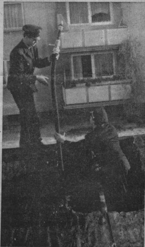
Zwei Feuerwehrmänner im Einsatz auf dem Dach der »Arche«.
