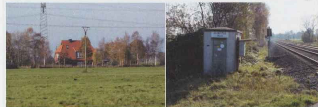
ehem. Bahnwärterhaus Hove
