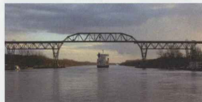
Eisenbahnhochbrücke bei Hochdonn
