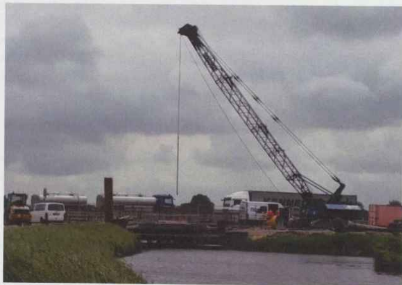
Brückenneubau B 5 über die Feldwettern 2017
