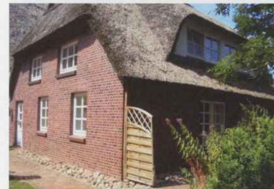
Ferienwohnungen in der Reetdachscheune
