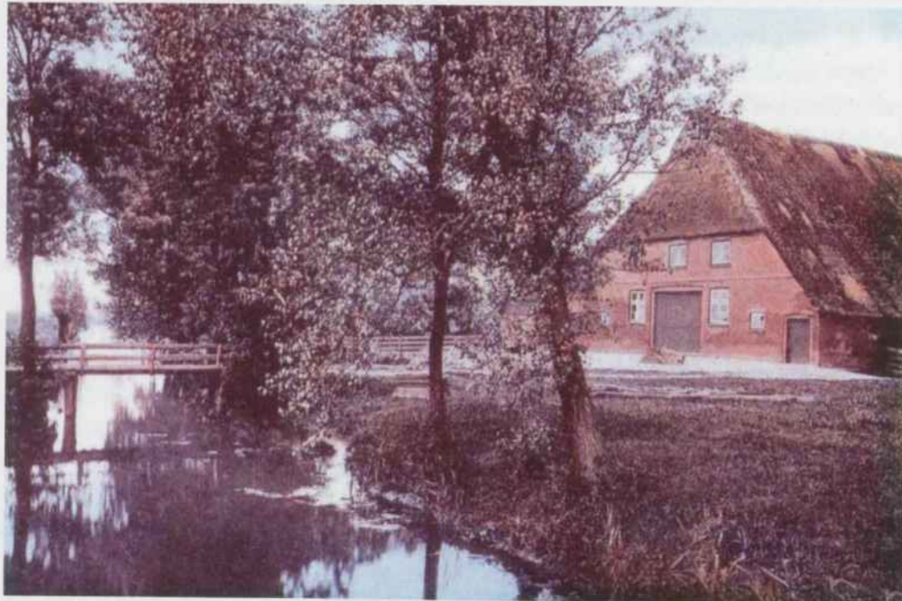
Hof um 1900 – Anm: Die Wetterern ist nicht mehr vorhanden
