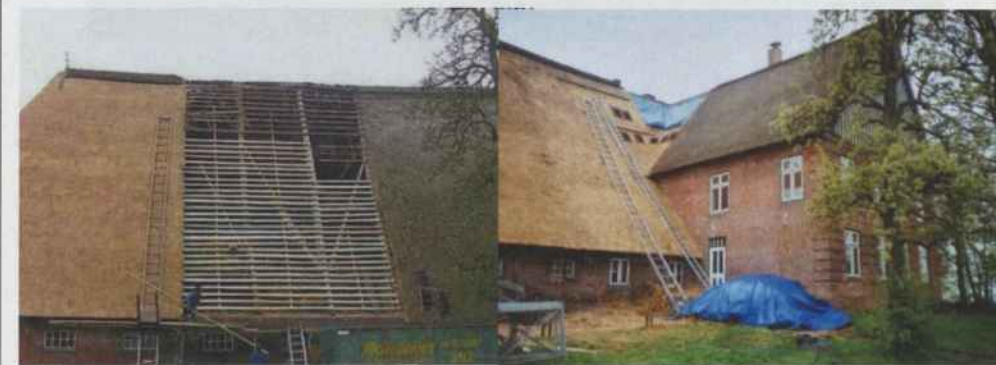
Neueindeckung Reetdach Heesch
