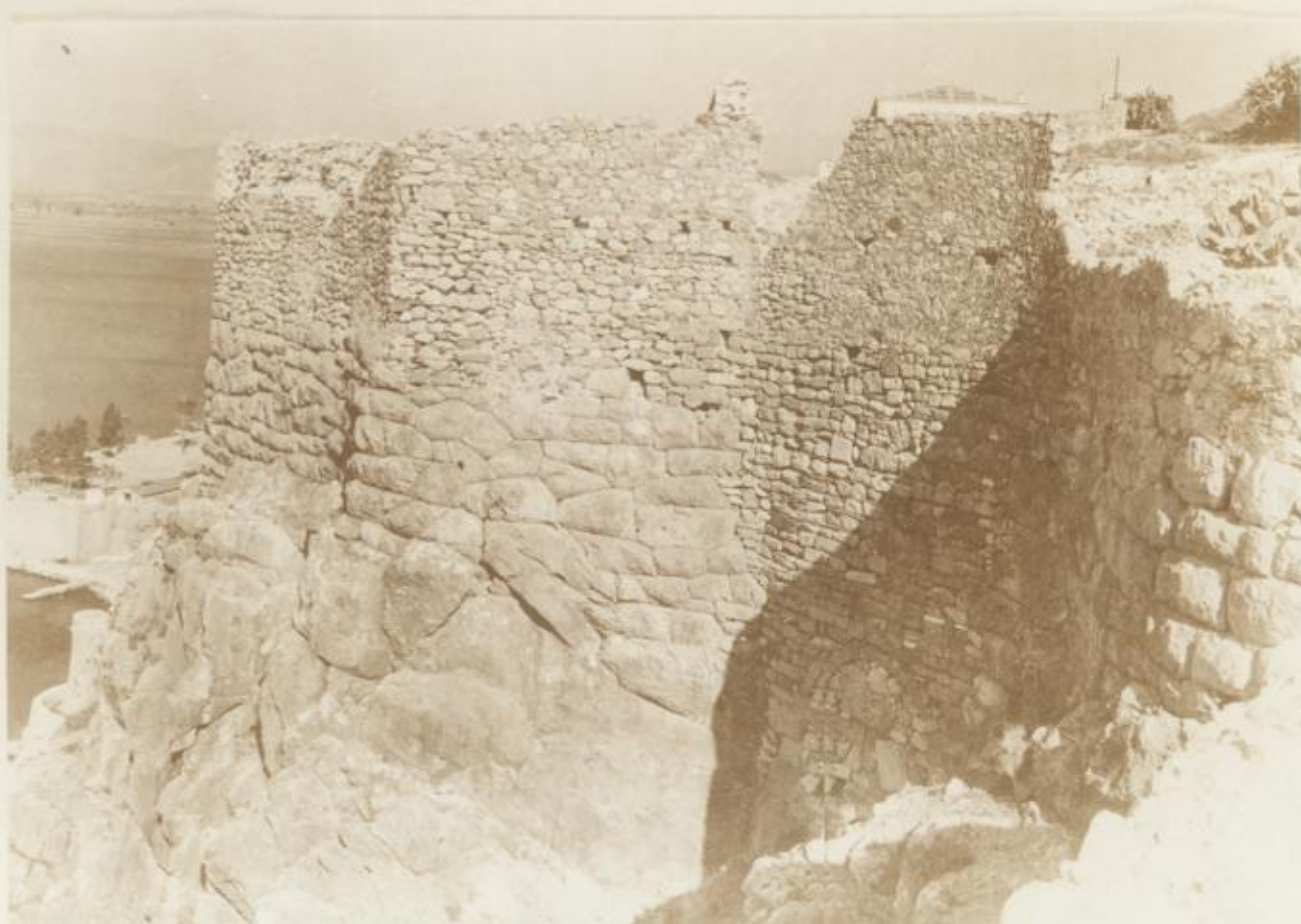
Abb.2b. Die vermauerte "Porta secreta" im Westteil der Stadtmauer.
