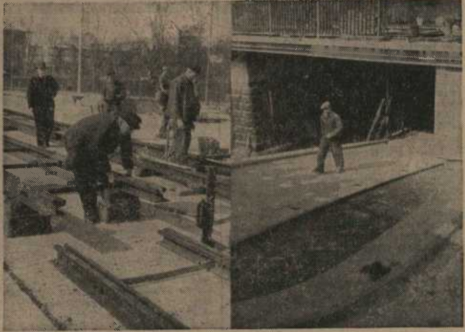
Die Arbeiten an der Alicebrücke schreiten gut voran. Links werden die Straßenbahngleise bereits auf die Fahrbahn gebaut, und rechts sieht man, daß die Fußgängerunterführung schon fast vollendet ist. Fotos: Karin Eckert
