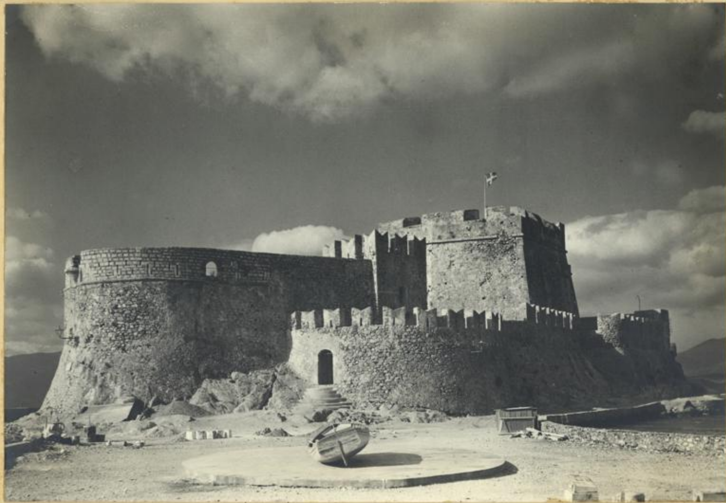
Bårdzı, vom Nordost-Eingang, nach Abbruch der höheren Zinnen. Fot. W. Wrede 1935
