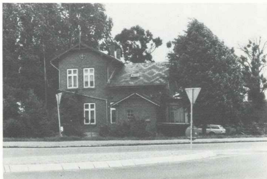
Hauptstraße Nr. 16: Siegfried Wichert 1982 – Catharina Biesterfeldt 1948 – Peter Heinrich Ehlers 1917 – erbaut 1899 Peter Ehlers.
