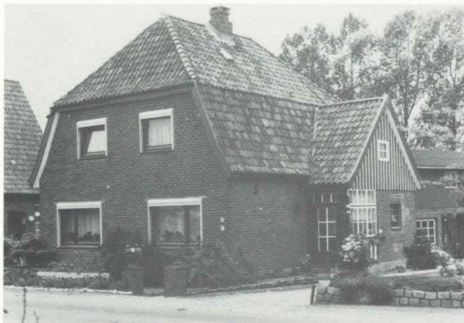
Grevenkoper Riep Nr. 13: Bertha Ehlers 1981 - davor Hans Ehlers 1953 - Johannes Brandt 1927 erbaut.
