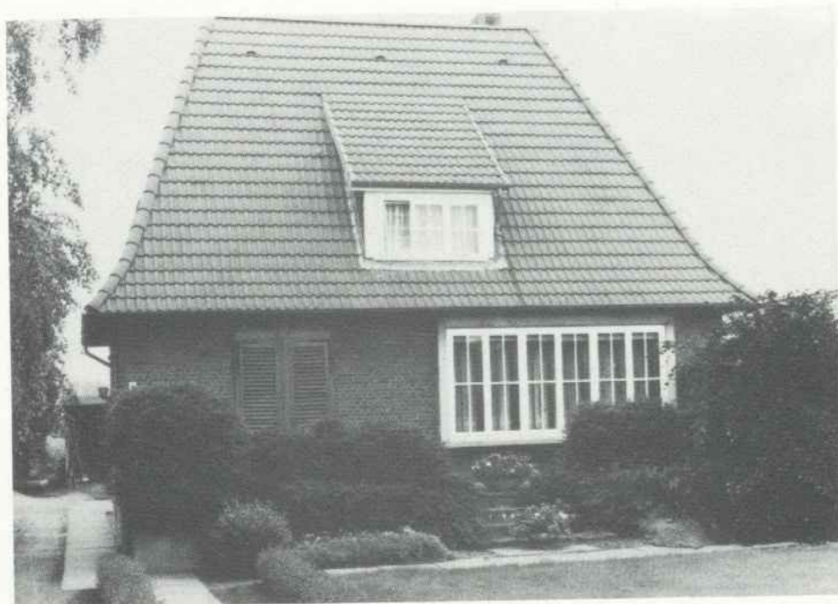
Grevenkoper Riep Nr. 19: Ingrid Harder 1977 / Willi Harder 1949 erbaut.
