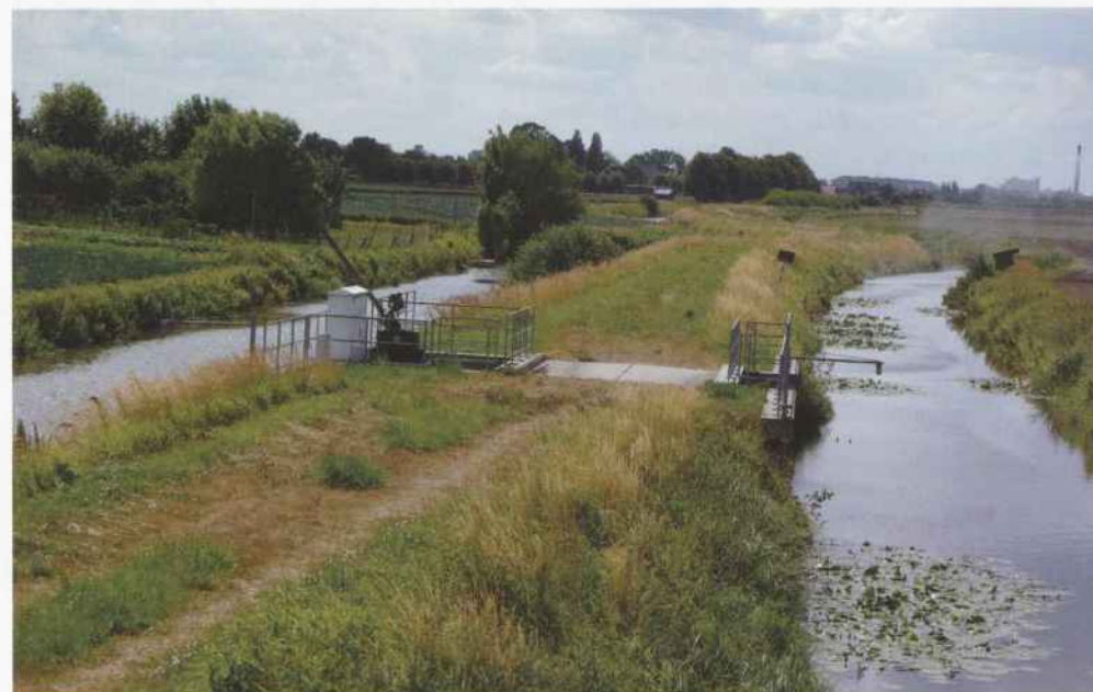
Entlastungsschleuse zwischen Schwarz- und Weißwasser am Altendeich
