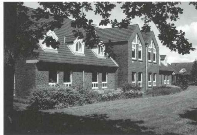
Ehem. Amtsgebäude in der Wilhelm-Ehlers-Straße
