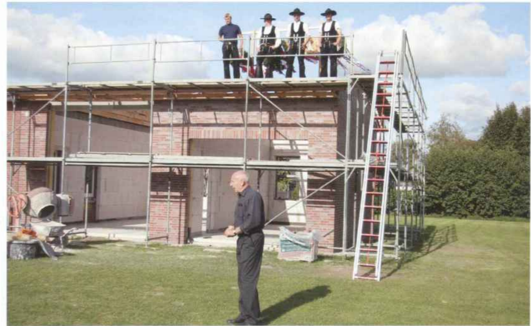
Richtfest des Anbaus am 11.09.2009
