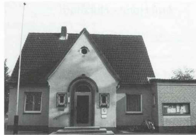
Ehem. Amtsgebäude in der Gartenstraße
