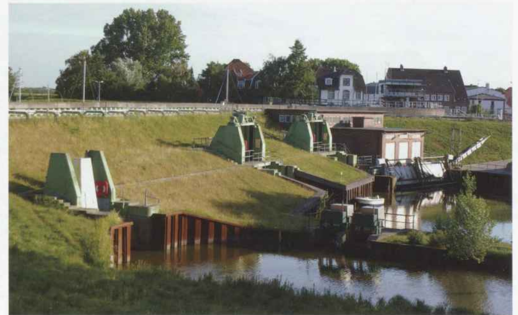
Hauptschöpfwerk in Glückstadt an der Rhinmündung mit Schwarzwasser
