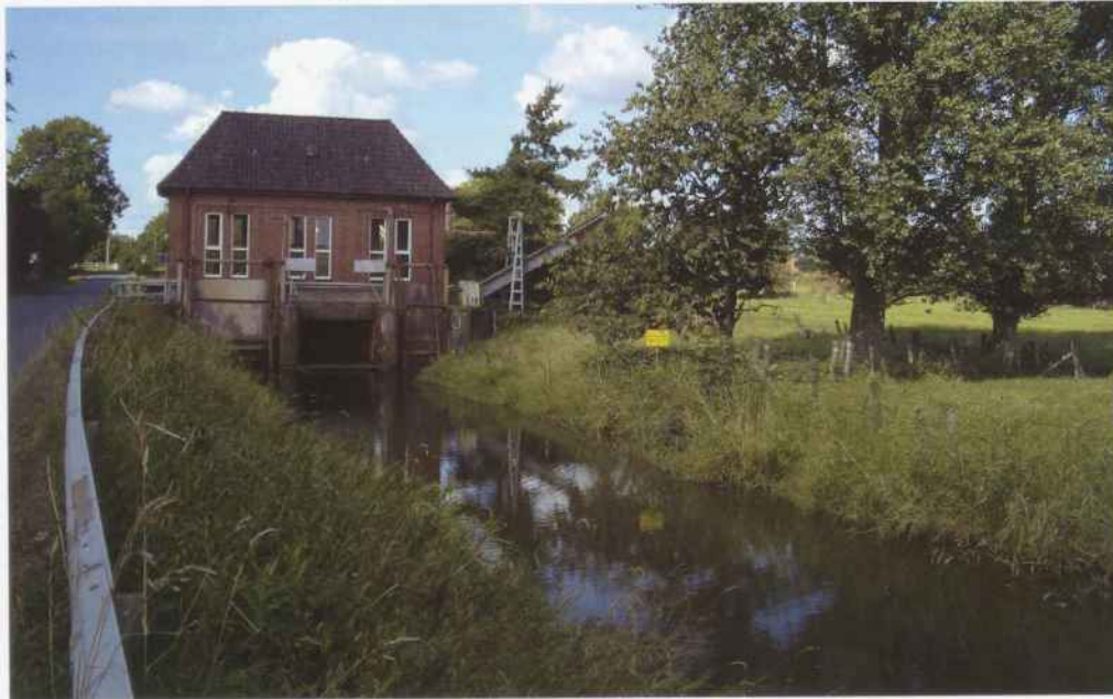
Unterschöpfwerk Herzhorn in Mittelfeld
