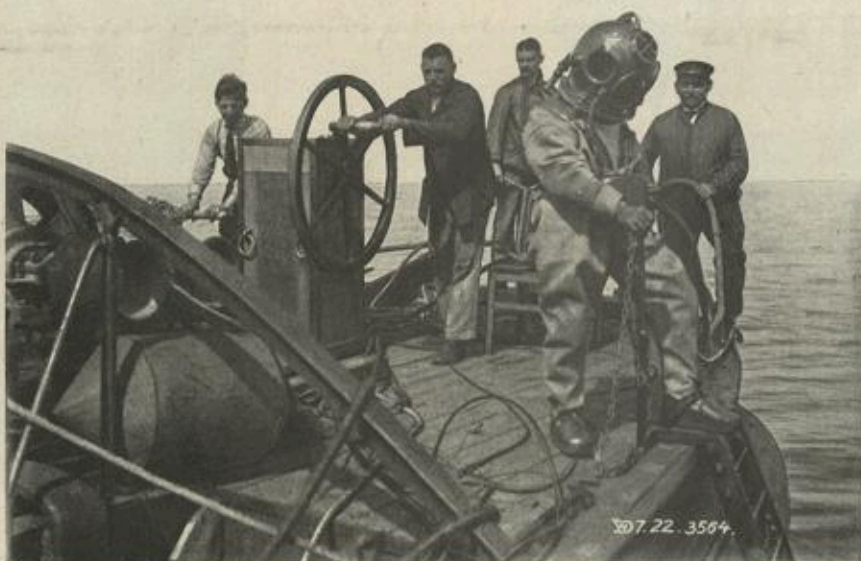
Bild 1. Dräger-Schlauchtauchergerät bei Bergungsarbeiten.
