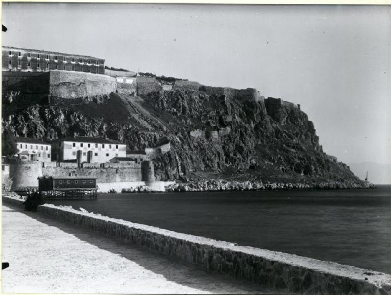
ARG. 323 WESTSCHENKEL DER NIEDERSTADTMAUER IM ANSCHLUSS AN AKRONAUPLIA
