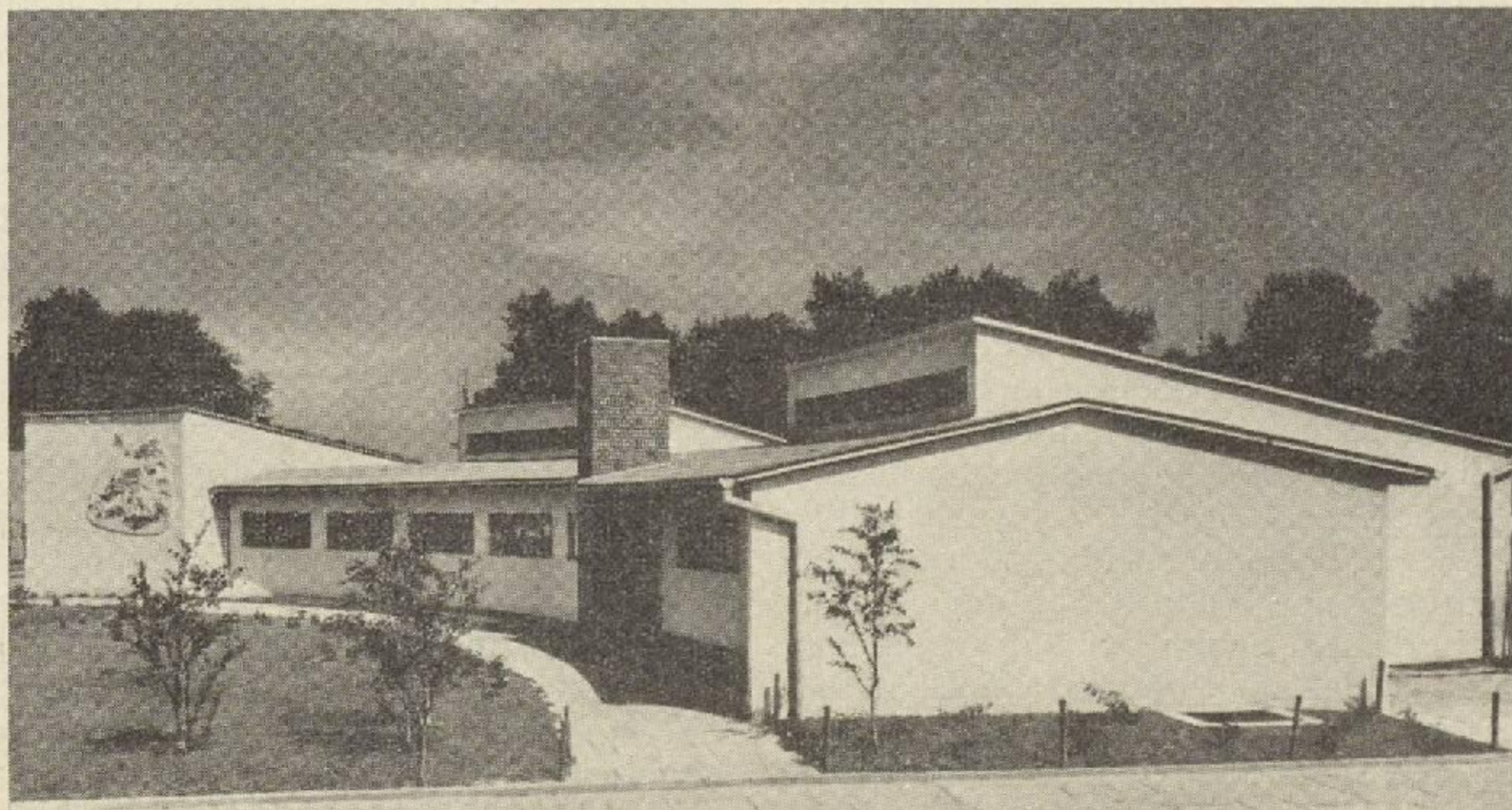
Kindergarten in der Schönausiedlung
