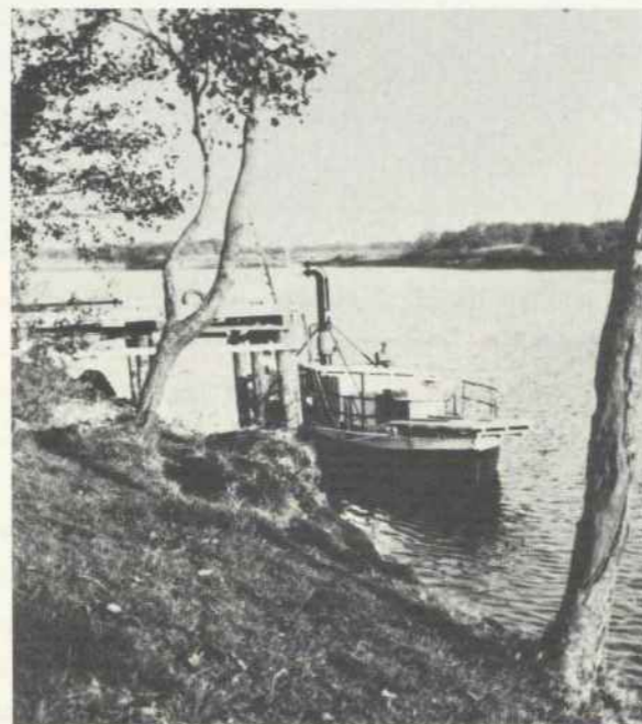
Abb. 46 1965, am 27. September wurde mit dem Leerpumpen der ehemaligen Kreidegrube Saturn begonnen.
