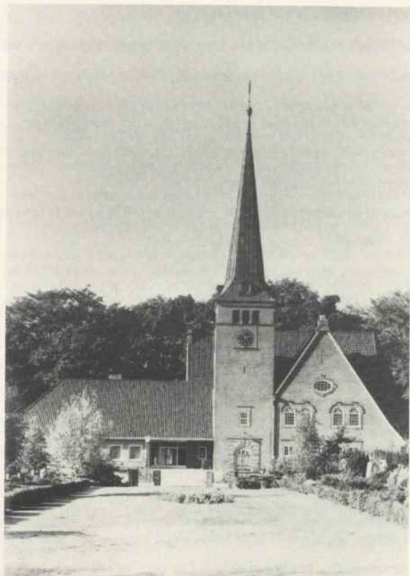
Abb. 96 1975, Ev. Kirche mit Anbau
