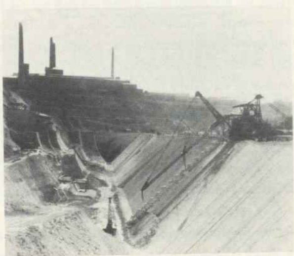
Abb. 38 1952, Anschnitt einer neuen Sohle in der Breitenburger Kreidegrube.
