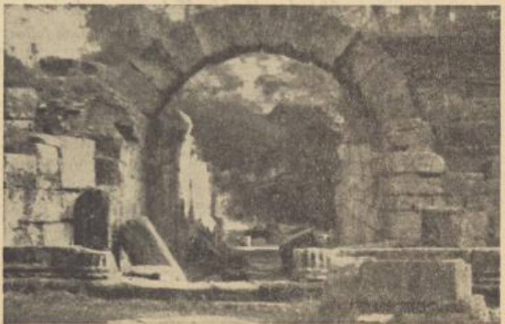
Eingang zum olympischen Stadion, dessen Freilegung nunmehr erfolgt. Foto: Helm. Selbmann
