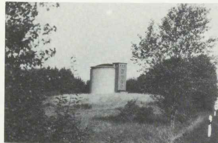
Der Wasserturm Wasser-Hochbehälter am höchsten Punkt des Ortes
