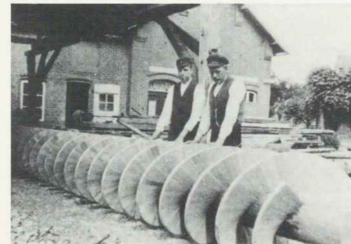
Heinrich Horns baute die hölzerne Schöpfschraube für die Windwassermühle
