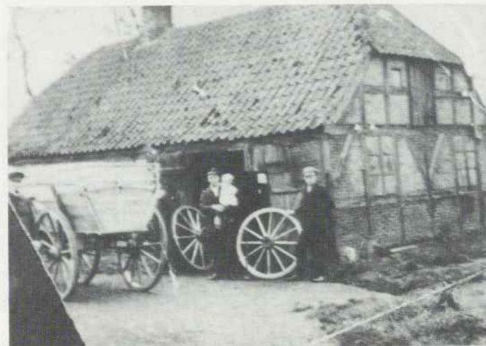
Das einzig vorhandene Bild der alten Schmiede (1925) Foto 141 von Waldemar Herzberg, ein Fachwerkbau aus der Zeit der Erstbebauung des Ortsteils Hofweg. Von links nach rechts: Waldemar Herzberg; Geselle Ernst Karau mit Alfred Herzberg; Hans Waage aus Vaalermoor
