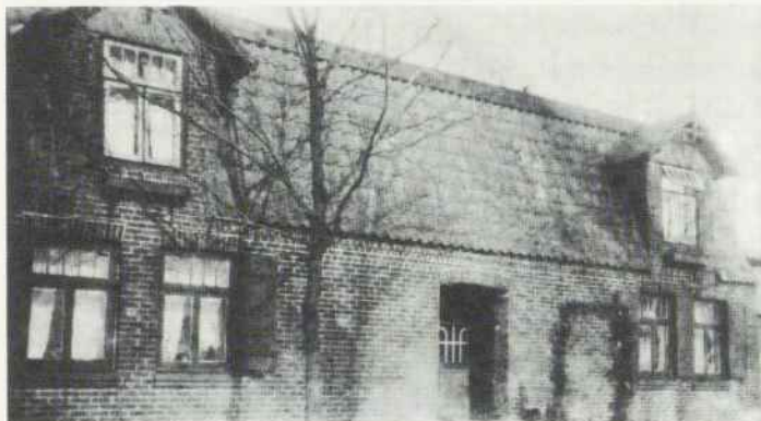
(1945) Hauptstraße 14, von Ella Struve 1926 umgebaut.
