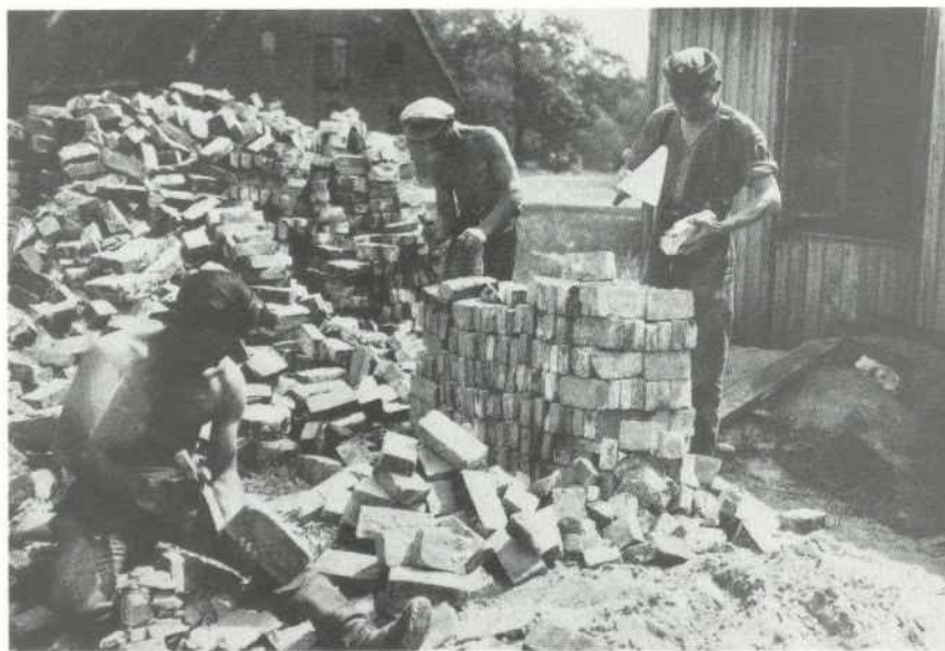
Abputzen der Steine für den Häuserbau
