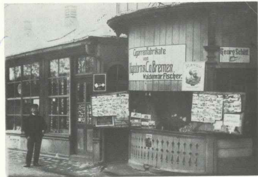
Links der sogen. Glaspalast, heute Imbiß, Kieler Straße 78.
