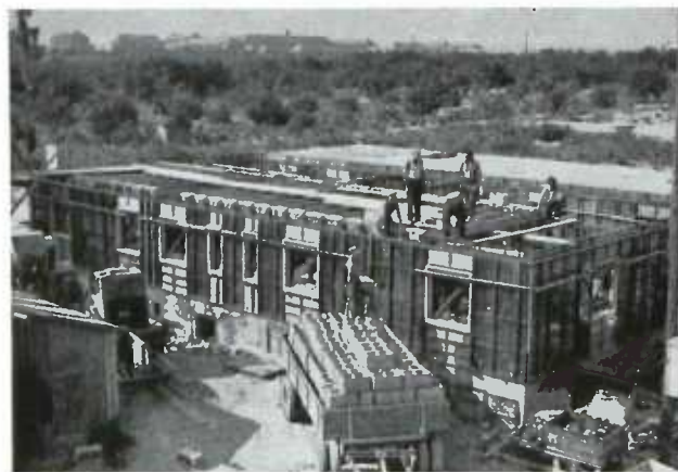
Abb. 46: Gitterschalung vor dem Betonieren
