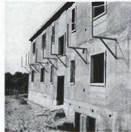
Abb. 53: Konsolgerüst System Kuske-Kronprinz
