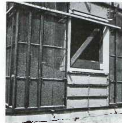
Abb. 47: Kunststeingewände in der Gitterschalung während des Betonierens
