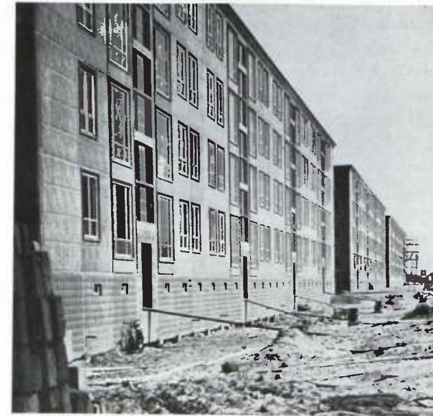
Abb. 57: Wohnhäuser in Holland aus Schokbetonfertigteilen
