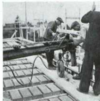
Abb. 51: Endstück des Gurtförderers und Einfülltrichter
