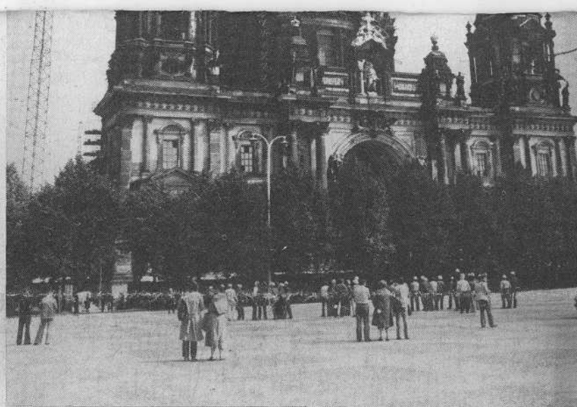
Am 18. August wurde der erneuerten Kuppel des Berliner Doms eine 15 Meter hohe Konstruktion mit vergoldetem Kreuz aufgesetzt
