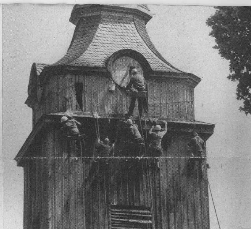
Bergsteiger der Gruppe „Technosport“ behandelten im Juli die Holzaufbauten des Kirchturms der unter Denkmalschutz stehenden Kirche in Basdorf, Kreis Bernau, mit Holzschutzmitteln gegen Holzwurmbefall und überholten malermäßig auch die Zifferblätter der Uhr.
