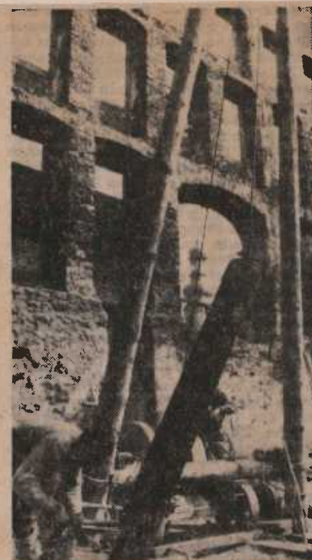
Die Gründungsarbeiten für den Neubau an der Ecke Mittlere Bleiche / Bauhofstraße sind in vollem Gange.
