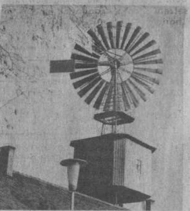
EIN WINDRAD, das im Jahre 1923 zum Antrieb einer Wasserpumpe eingerichtet und später durch Elektrizität ersetzt wurde, ist jetzt in der ungarischen Landwirtschaftsschule Karcag wieder in Betrieb. Foto: ZB/MTI
