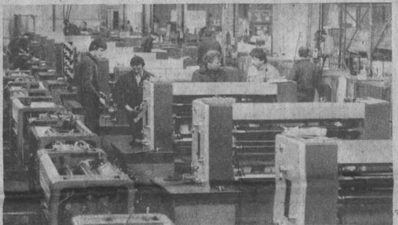
POLYGRAPHISCHE MASCHINEN aus der DDR gehören beim bedeutenden Exportpartner UdSSR, in anderen RGW-Ländern und bei Kunden in allen Kontinenten zu geachteten Erzeugnissen. Druckwerke für Bogenoffsetmaschinen werden hier im VEB Druckmaschinenwerk VICTORIA Heidenau produziert. Ein mikroprozessorgesteuertes Verstellsystem für das Farbwerk, ein Jahr früher als geplant in die Fertigung übergeleitet, erhöht wesentlich die Gebrauchswerteigenschaften der Maschinen. Foto: ZB/Hinkel
