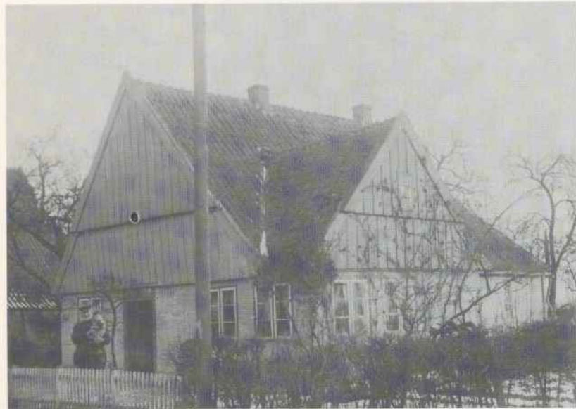
ABBILDUNG 38 Das Küblsche Haus in Neuenkirchen
