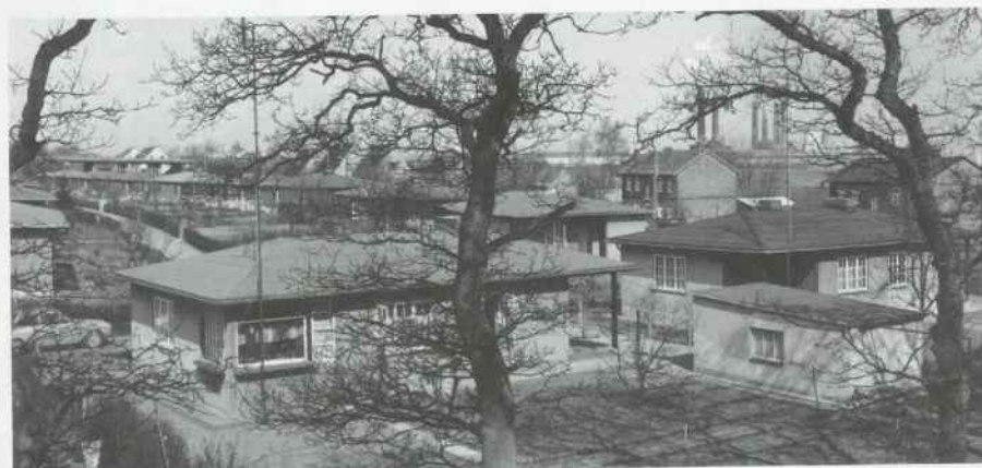
Abb. 81: Siedlungshäuser der Firma Alsen in Schulenburg in den 1960er Jahren. An die Alsenmitarbeiter (Vorarbeiter und Meister) wurden Bauplätze verlost. Die Häuser wurden in Eigenleistung erbaut. Die Rückzahlung in Raten an die Firma ist so berechnet worden, dass Grund und Boden erst Eigentum wurde, wenn der Mitarbeiter in Rente ging.
