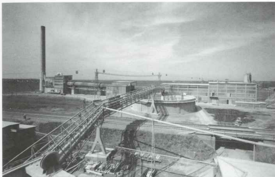
Abb. 41: Ansicht 1960er-Jahre, im Hintergrund Ofen 2, der längste Nassofen Europas mit 165 Metern
