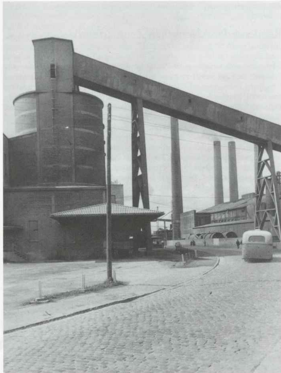
Abb. 50: Verladestation für LKW und Bahn mit Transportbrücke, 1952
