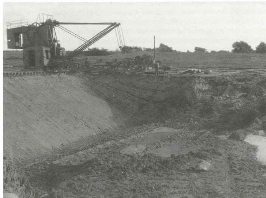
Abb. 19: Eimerkettenbagger in der Tongrube Wacken um 1914.
