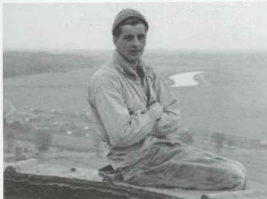
Abb. 77: Gerhard Sonnenburg auf dem höchsten Schornstein (75 Meter)
